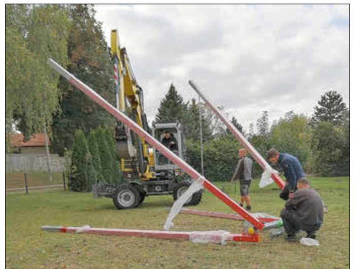
Der Aufbau der Seilbahn
